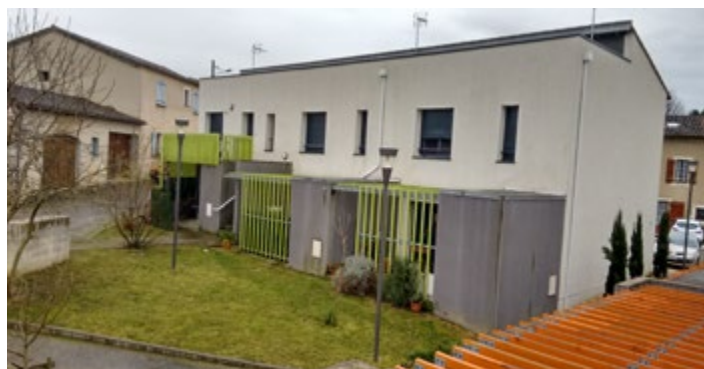
En cœur de parcelle, façades rehaussées de pergolas colorées donnant sur un espace public végétalisé - Photos © ADEME / CeRCAD
